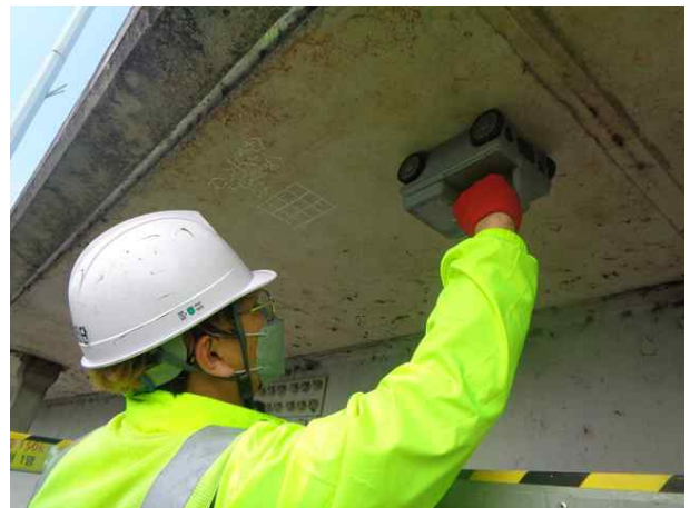
철근탐사 시험 - 피복깊이 측정
